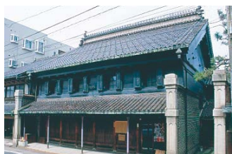
山町土蔵造りの町並み (画像提供:高岡市)
