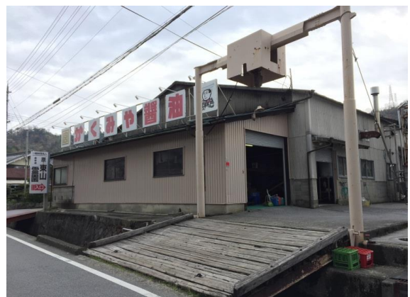
お土産にお渡しした 文政元年創業「かくみや醤油」の工場。 道と工場にかかる橋は増水時に引上げできる造り。
